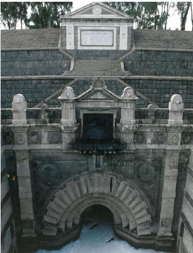
Figure 6. Entrée du Premier Tunnel de Tequixquiac.
