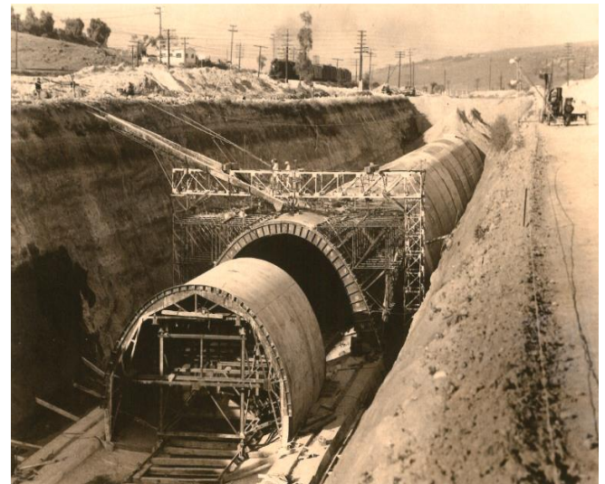
Figure 12. Construction de l'Interceptor del Poniente (1964).
