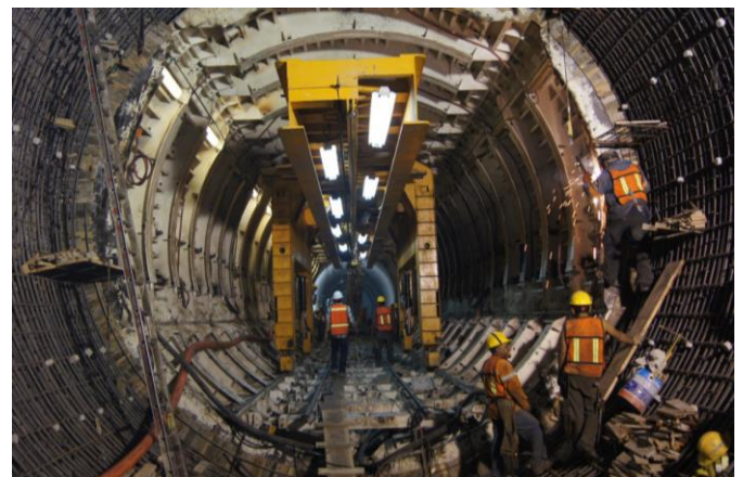
Figure 26. Installation du revêtement, Túnel Emisor Oriente.
