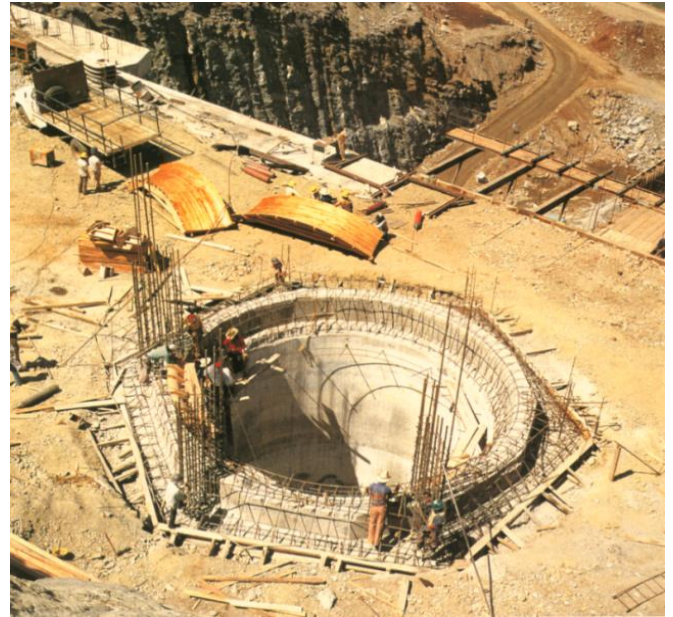
Figure 10. Construction d'un des regards de l'Emisor Central (1970)
