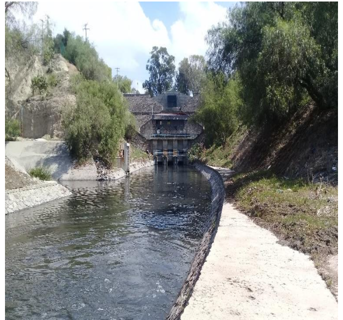
Figure 4. Gran Canal del Desagüe à la conexión avec le Segundo Túnel de Tequixquiac.
