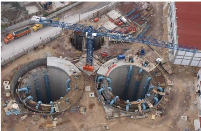
Figure 13. Construction de la SP El Caracol.
