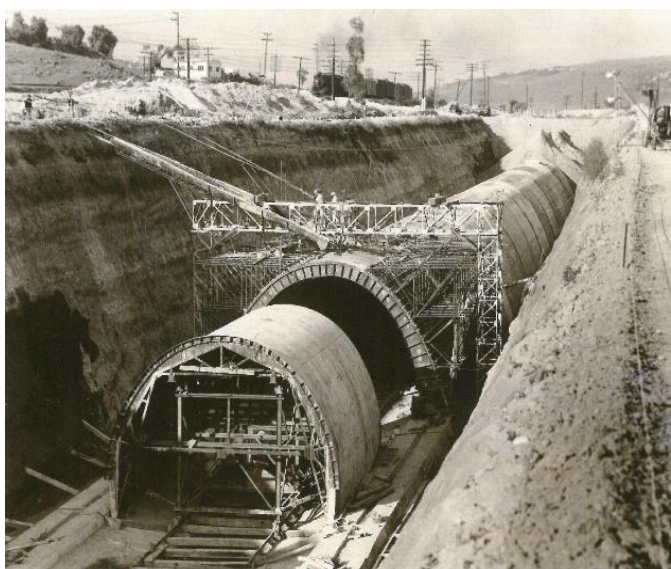
Figure 8. Construction de l'Emisor Poniente, ICA (1964).
