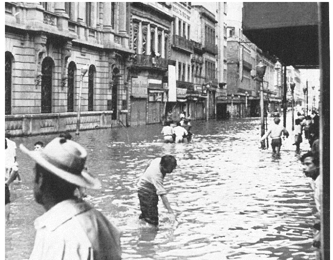
Figure 4. Inondations du centre-ville au début du XXème s.
