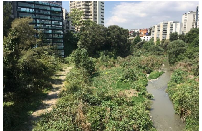
Figure 6. Constructions dans le lit du barrage de Tecamachalco.
