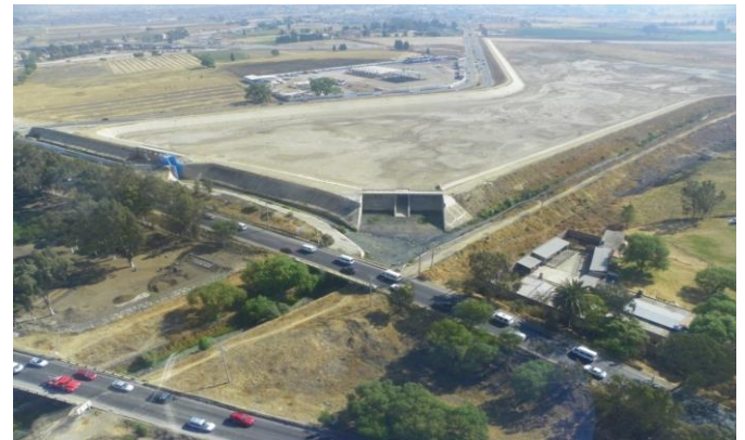
Figure 17. Presa La Gasera.
