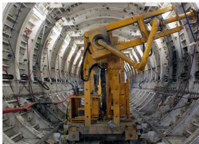
Figure 12. Construction du Túnel Emisor Oriente.
