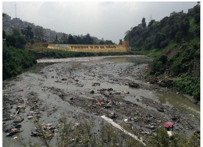
Figure 11. Barrage de régulation C de Becerra (on note que la présence d'une quantité importante de sédiments et de déchets ont compromis la capacité de stockage).
