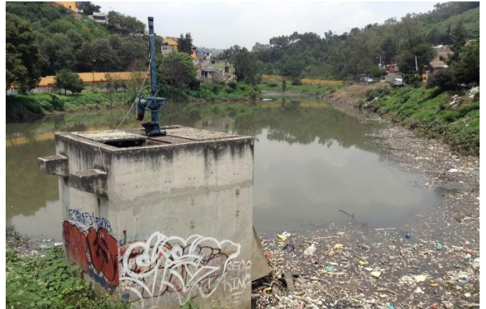
Figure 11. Barrage de régulation C de Becerra (on note que la présence d'une quantité importante de sédiments et de déchets ont compromis la capacité de stockage).
