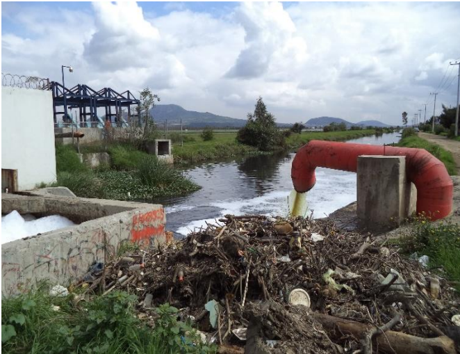
Figure 12. Canal General, Station de pompage Parada del Toro.
